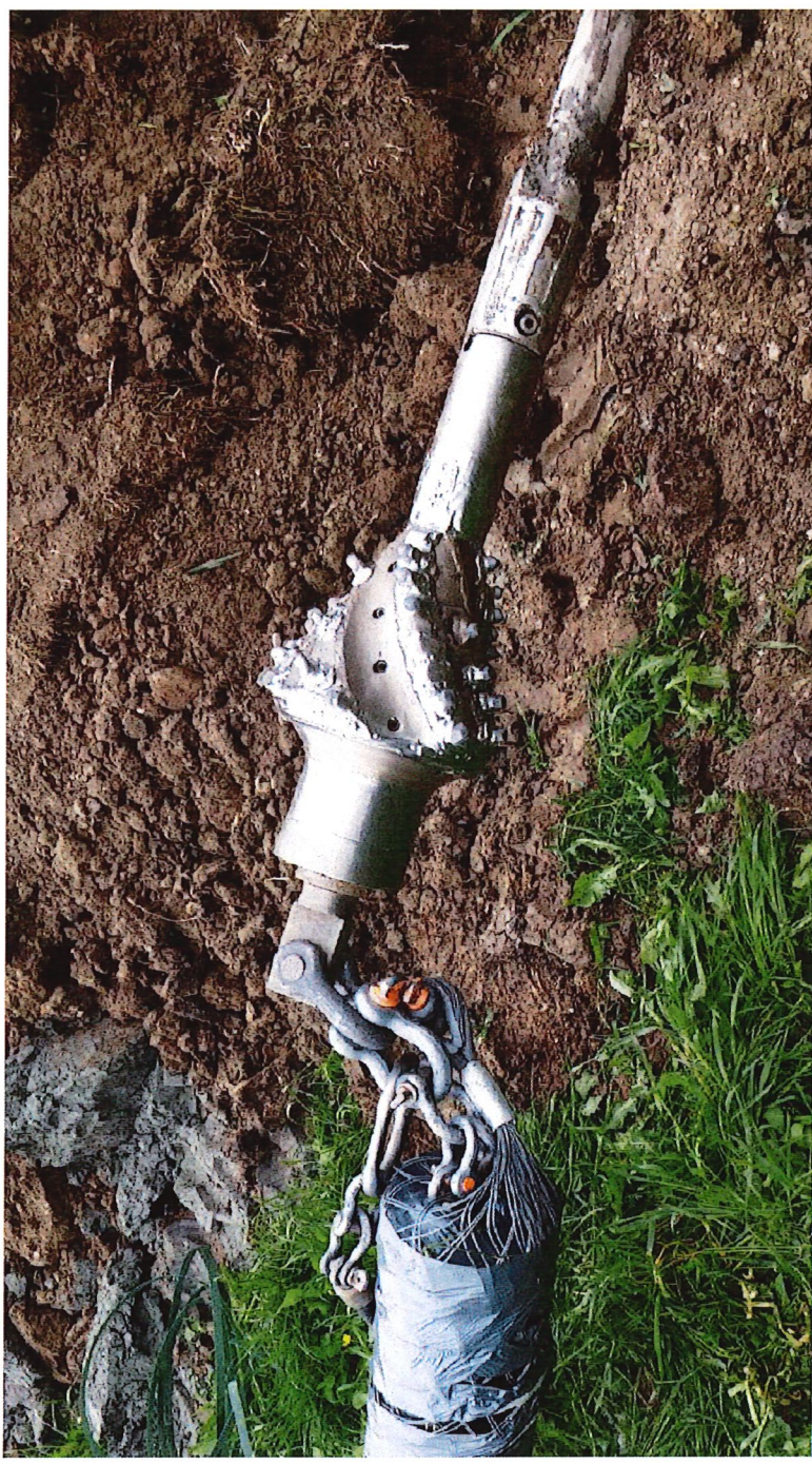
Grabenlose Verlegung im günstigen Spülbohrverfahren
