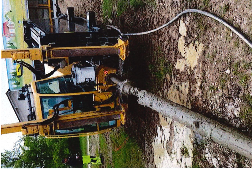
Grabenlose Verlegung im günstigen Spülbohrverfahren
