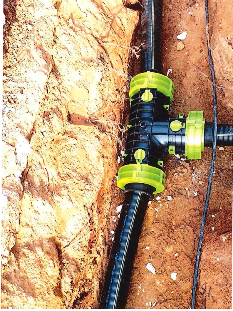
T-Stück im offenen Graben
